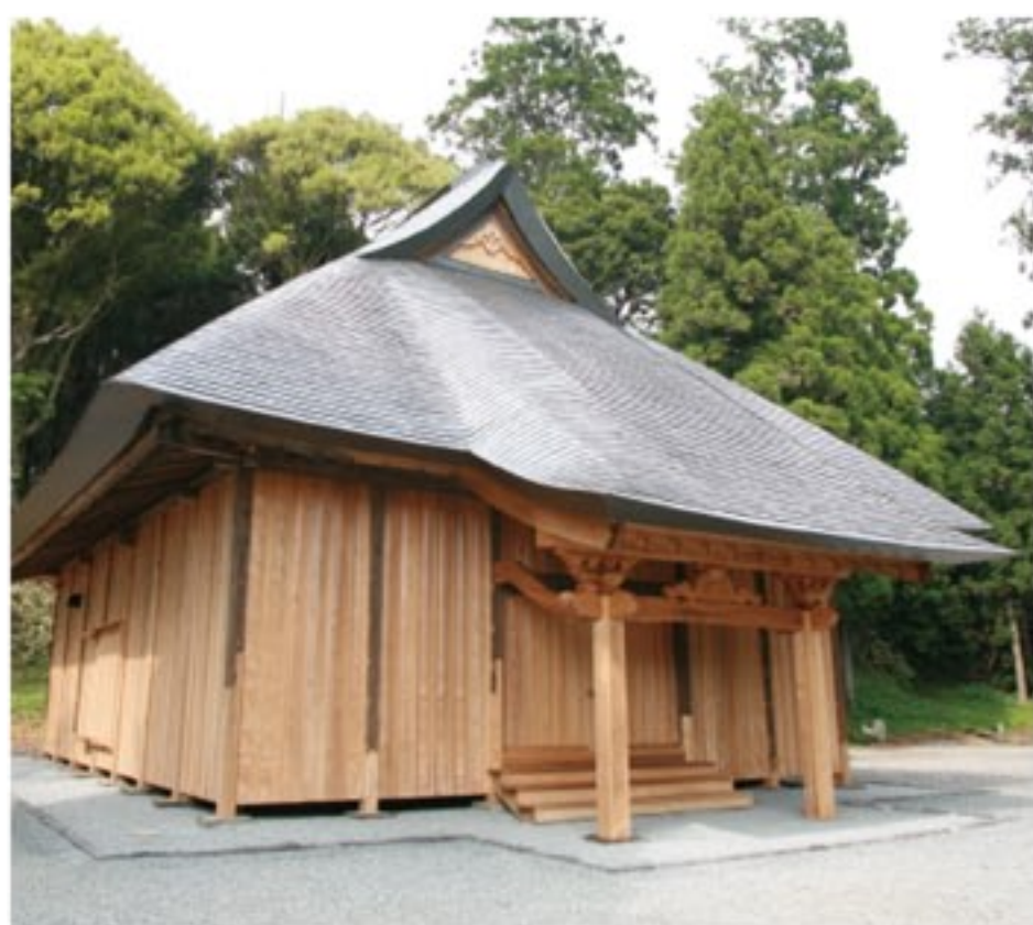
保存修理工事が完了した富士山興法寺大日堂 (富士宮市村山)
