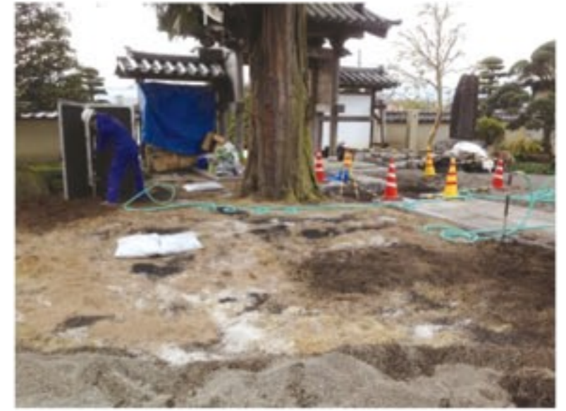
土壌改良をしている作業中
