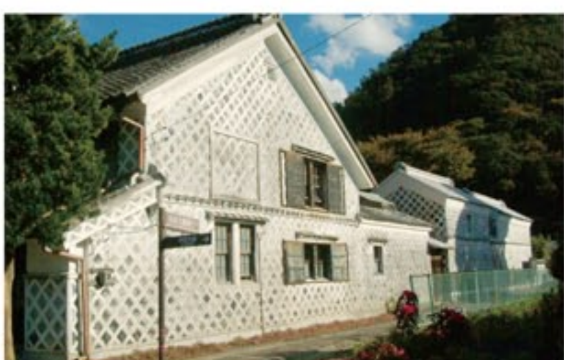
なまこ壁の建物
