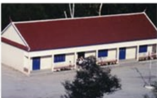
佐野さんが私費を投じて建設した小学校。教室は3つあり、現在も使用されている。
